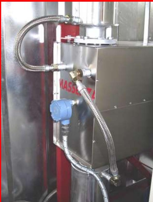
ПОКРЫТАЯ КОЖУХОМ МАССОВАЯ СИСТЕМА ИЗМЕРЕНИЯ РАСХОДА МАТЕРИАЛА, РАБОТАЮЩАЯ ПО ПРИНЦИПУ КОРИОЛИС. ИЗМЕРЯЕТ МАССОВЫЙ РАСХОД НЕПОСРЕДСТВЕННО, НЕЗАВИСИМО ОТ ЛЮБЫХ ДРУГИХ ПАРАМЕТРОВ ЖИДКОСТИ, ТАКИХ КАК ПЛОТНОСТЬ, ТЕМПЕРАТУРА, ДАВЛЕНИЕ, ВЯЗКОСТЬ, ПРОВОДИМОСТЬ И ПРОФИЛЬ ПОТОКА. УСТАНОВЛЕН СО СПЕЦИАЛЬНОЙ РАМКой ПОДДЕРЖКИ И ГИБКИМ ТРУБОПРОВОДОМ, ЧТОБЫ ИЗБЕЖАТЬ ОТРАЖЕННОЙ РЕЗОНАНСНОЙ ЭНЕРГИИ ИЗ ВНЕШНЕГО ИСТОЧНИКА И ОБОРУДОВАН МАСЛЯНОЙ РУБАШКОЙ ОБОГРЕВА. DN80, PN16,
